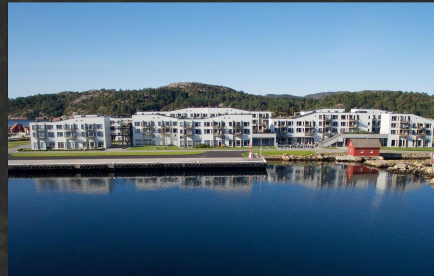
Lindenes Havhotell (under installasjon)
