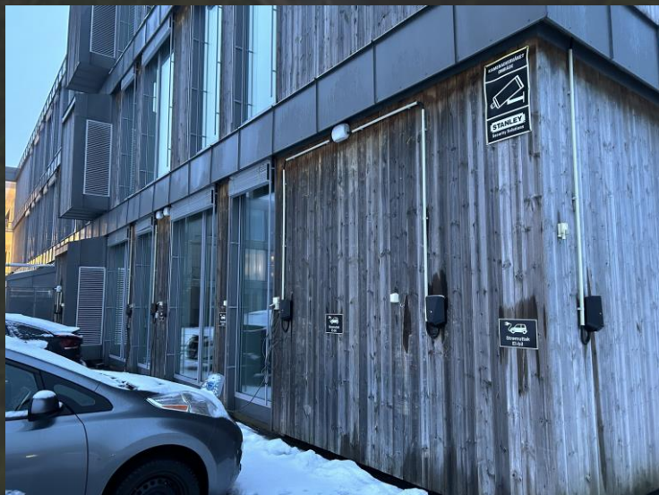
Næringsbygg/kontor, Sørlandsparken 12 stk ladere
